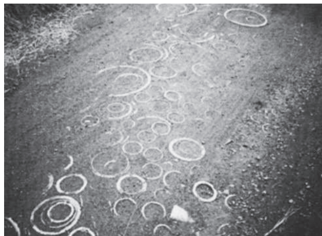
Fot. 1. Droga utwardzona odpadami azbestowo-cementowymi na terenie gminy Szczucin (wg Środowisko 17 (353)/2007)
