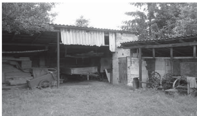
Fot. 2. Zagospodarowanie wyrobów azbestowych do celów użytkowych na terenie gminy Szczucin
